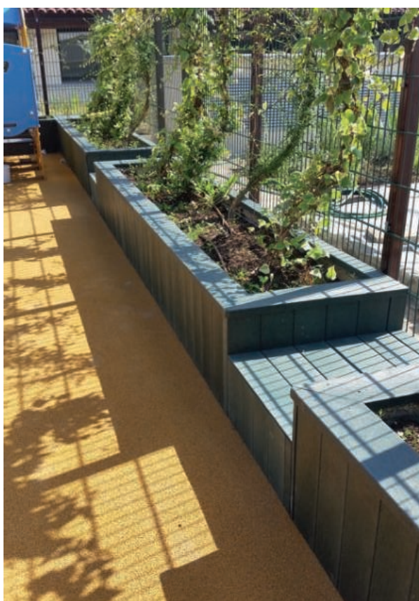
Rénovation de jardinières existantes
