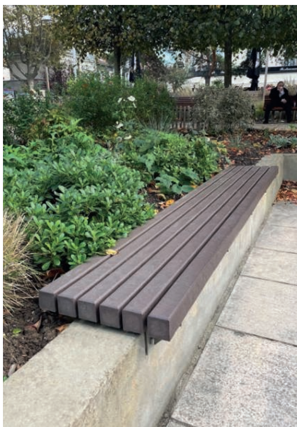
Assise sur muret
