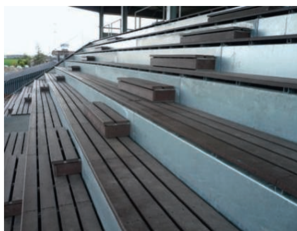
Rénovation de gradins
