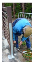
Platine de fixation avec renfort
