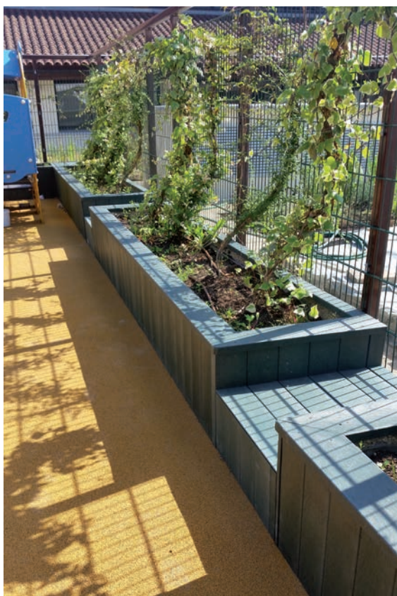
Rénovation de jardinières existantes
