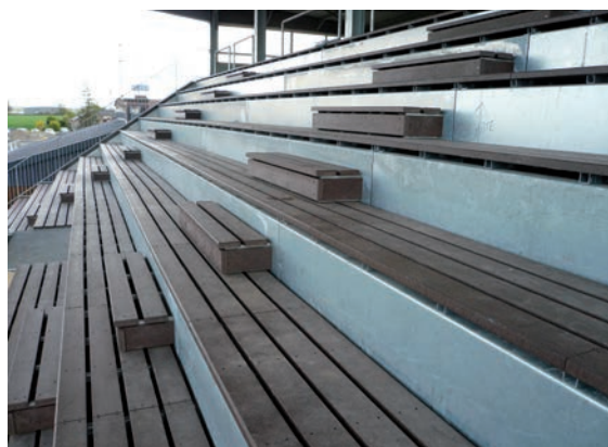
Rénovation de gradins
