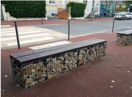
Assises sur gabions
